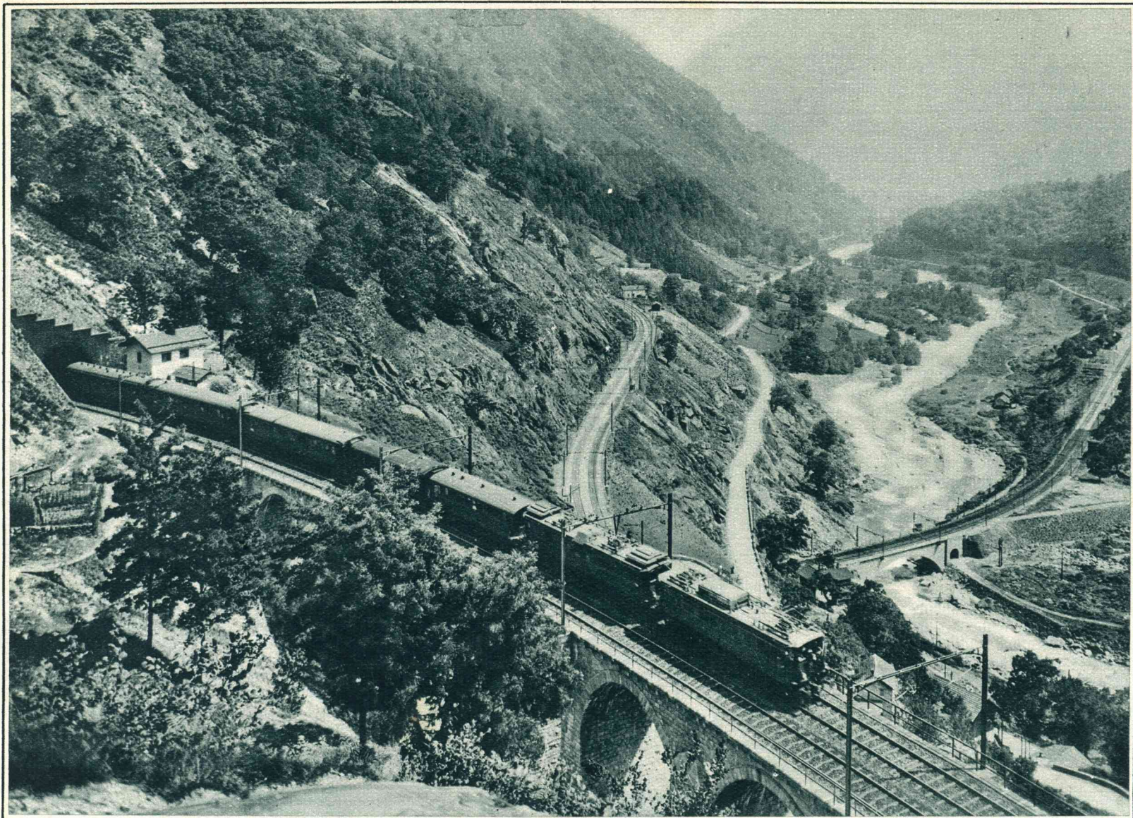
De St Gotthardspoorweg in Zwitserland is in zig-zaglijn tegen de steile hellingen van den berg opgebouwd — en geldt terecht als een van de knapste ingenieurswerken van Europa.
