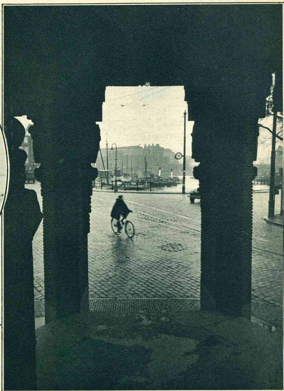
Doorkijk naar het Centraal Station, vanuit het por- tiek van het Scheepvaarthuis.
