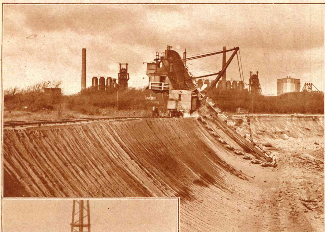
Een „excavateur” om het Spuikanaal op diepte te brengen.
