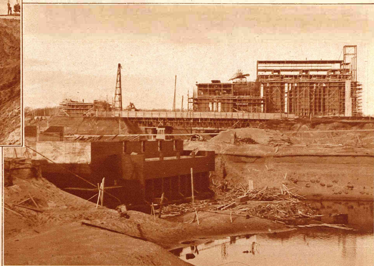
Gezicht op de in aanbouw zijnde nieuwe Centrale der P. E. N., met links het nieuwe koelwaterkanaal.
