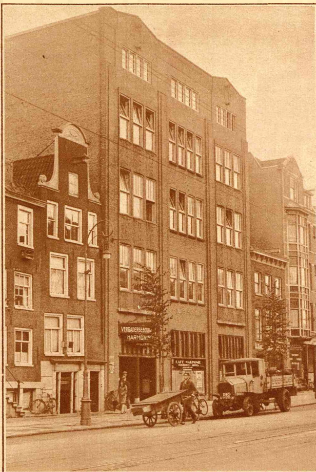
Modern verenigingsgebouw naast woonhuizen met een „steen” in den gevel.
