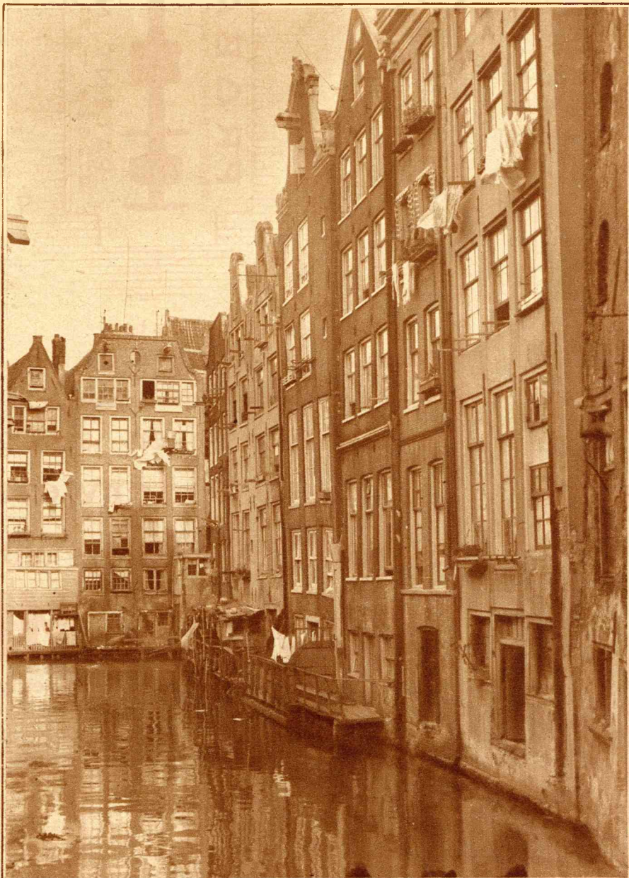
De achterzijde van den Zeedijk te Amsterdam, gezien van de brug bij de Spooksteeg.
