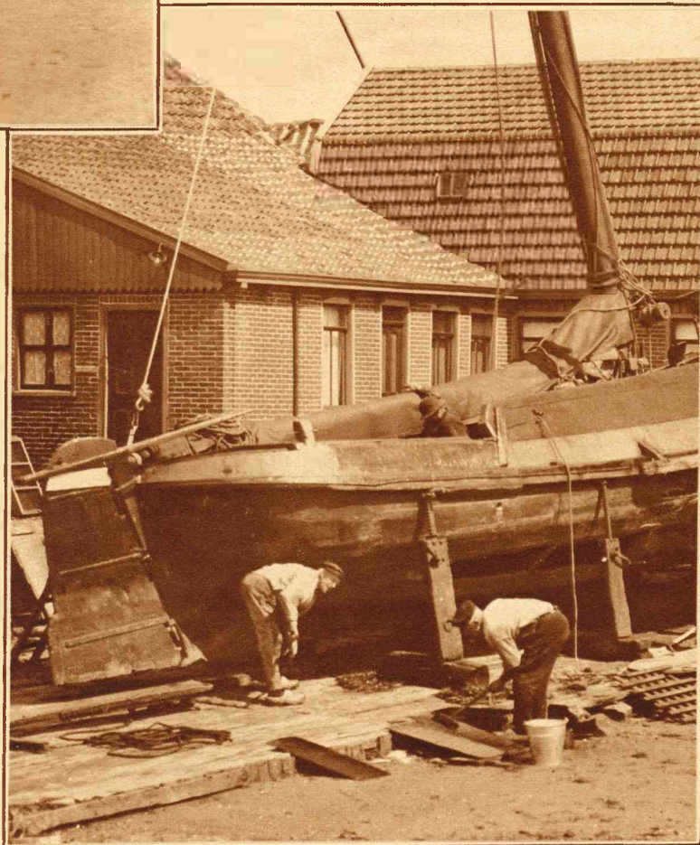
Herstellingswerken aan Texelsche visscherscheepjes.
