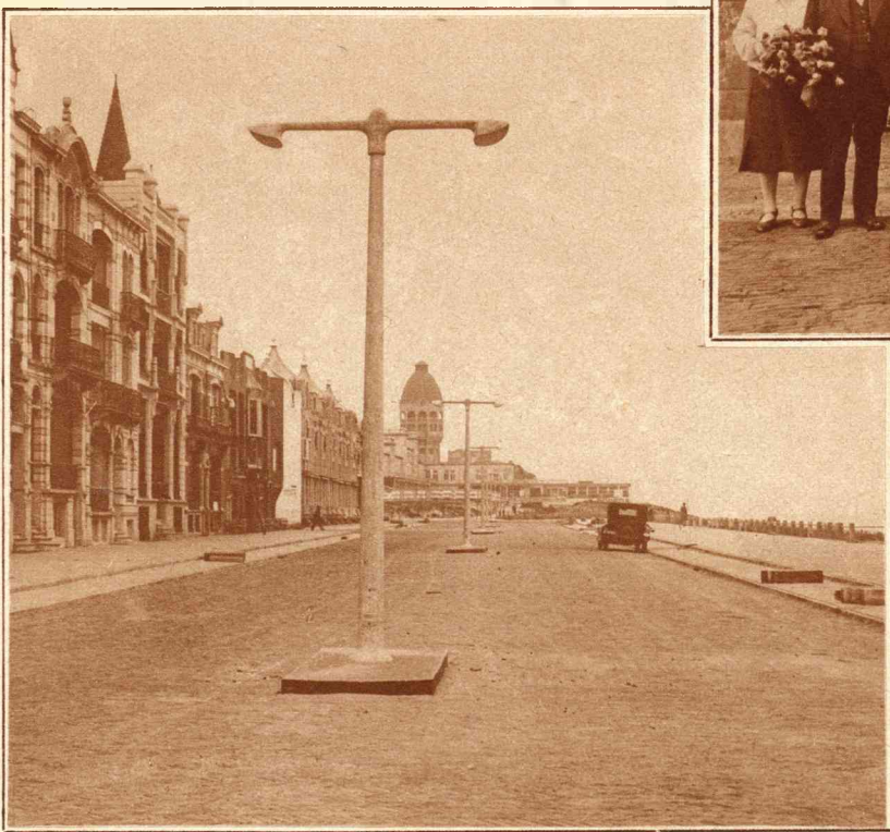
De boulevard Fauvage te Zandvoort is aanmerkelijk verbreed en gemoderniseerd. Een goede verbetering bij het seizoen-begijn.
