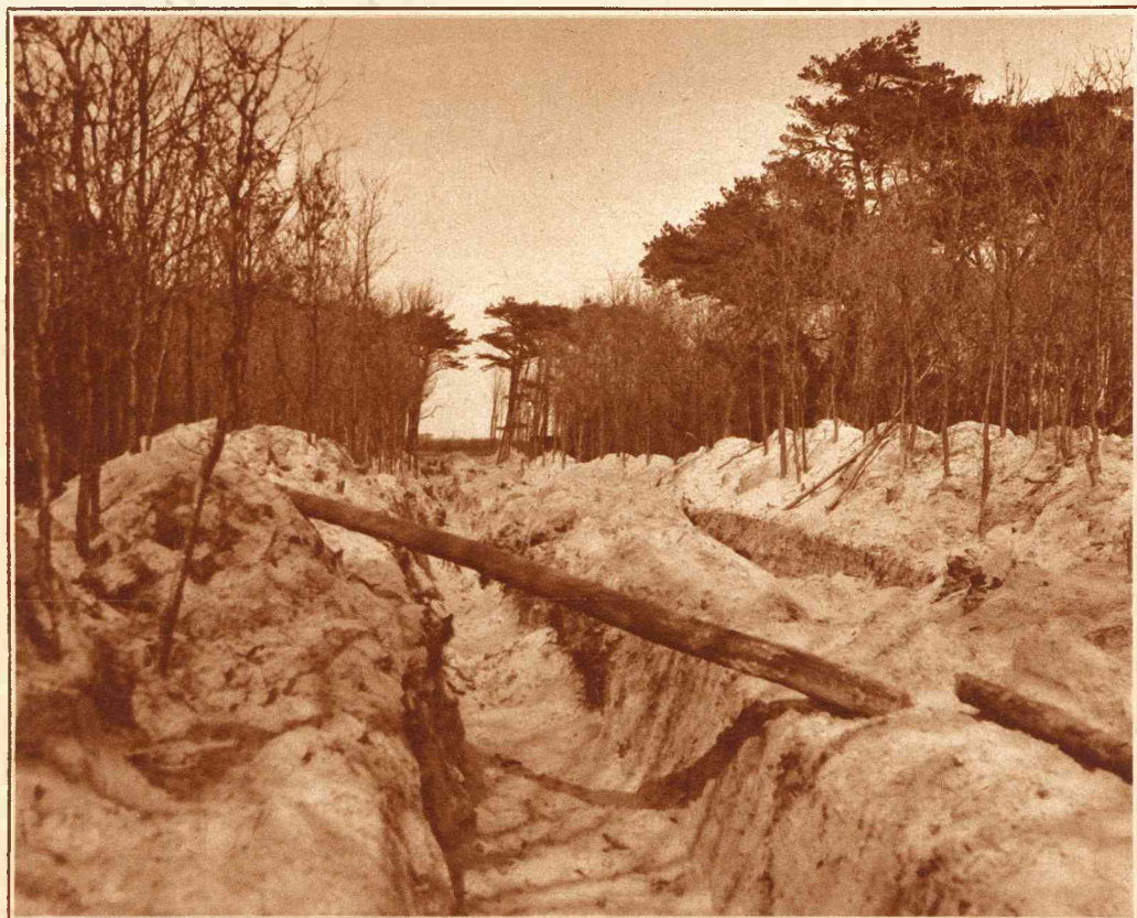
De weg voor de buizen is gereed gemaakt.
