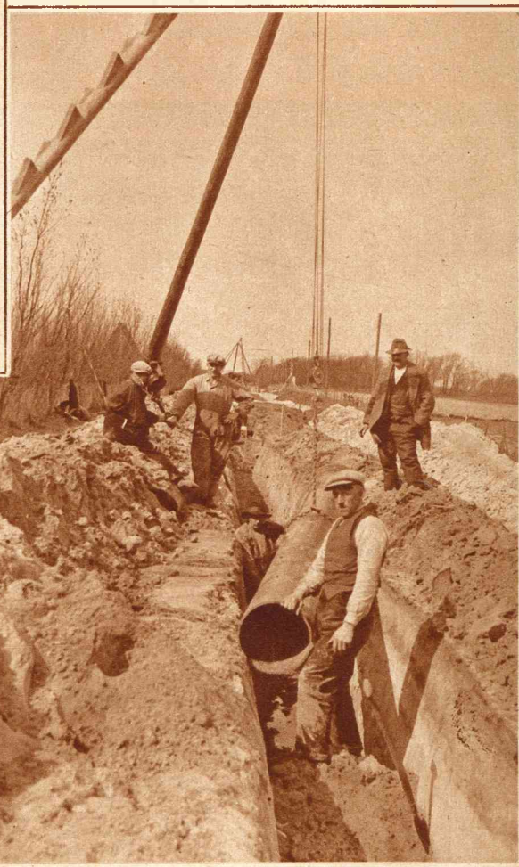
Het leggen van de buizen.
