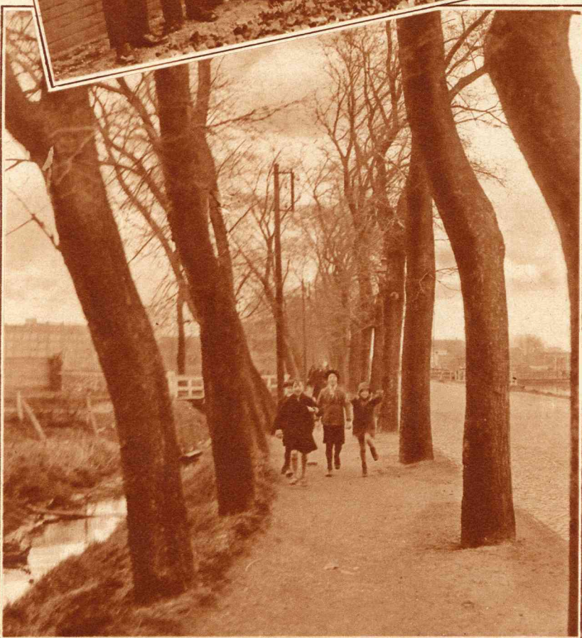
Een begin is gemaakt met de verbreding van den Haarlemmerweg nabij Sloterdijk. Het aardige laantje zal ter wille van het verkeer moeten verdwijnen, evenals verschillende huizen.
