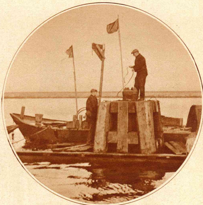
In het Noordzeekanaal op de grens van het IJ wordt een roode baken geplaatst ter regeling van het verkeer te water.
