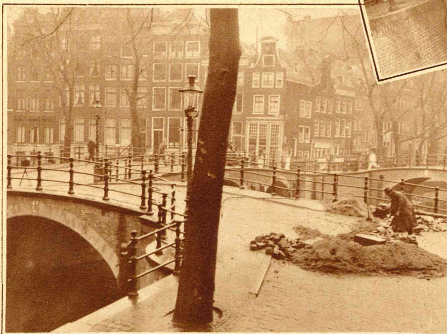
Het bruggencomplex over de Reguliersgracht.
