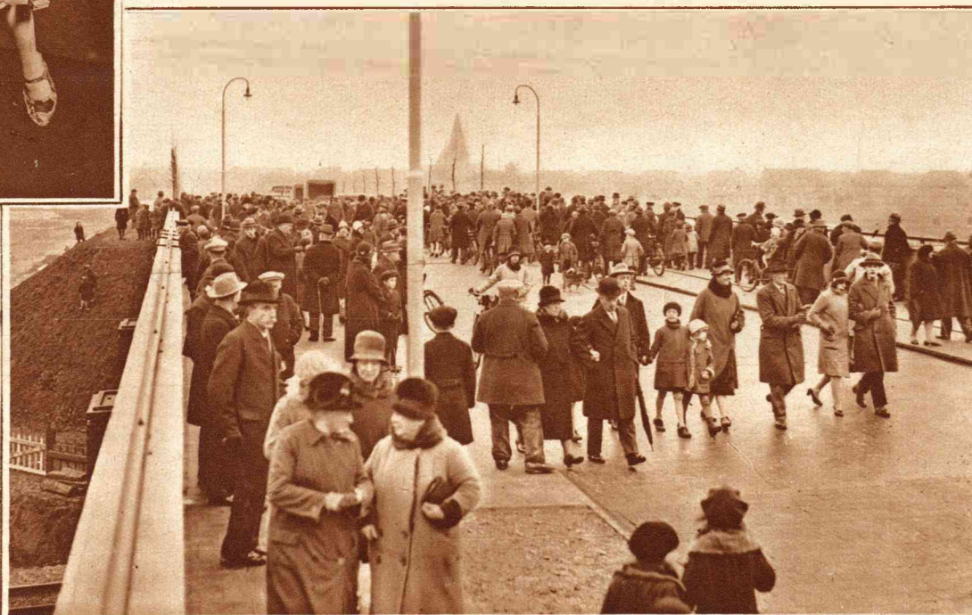
HET NIEUWE VIADUCT over de spoorlijn Amsterdam-Amersfoort te Hilversum is officieel in gebruik genomen. De eerste liefhebbers.
