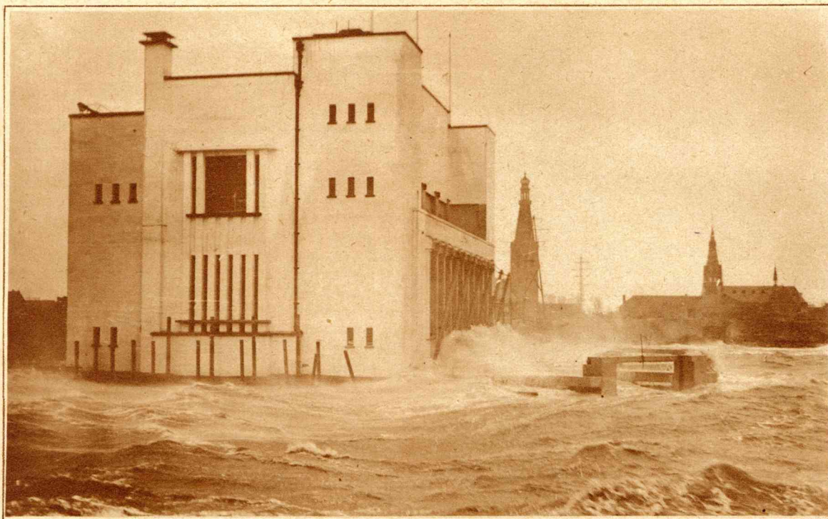
← Het nieuwe elektrische gemaal van den Wieringer-meerpolder nadert zijn voltooiing. Nu de tijdelijke omringdijk van dit bouwwerk is weggebaggerd staat de benedenverdieping rondom in het water.
