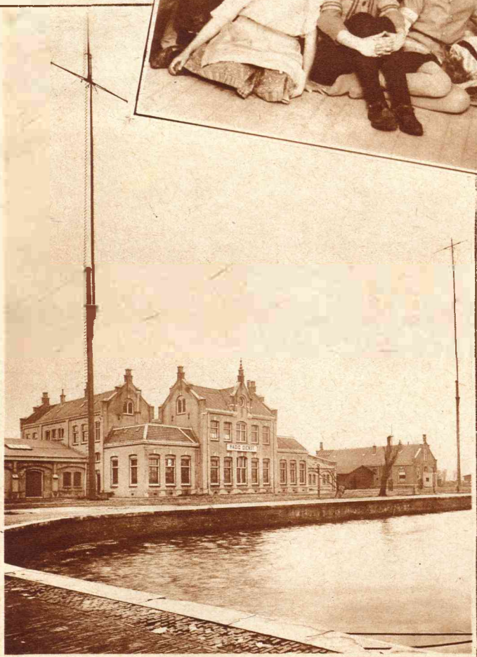
Het Radiostation en magazijn van ons Marine-etablissement.
