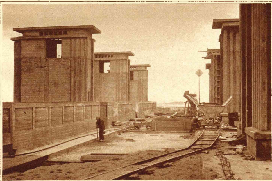
BOVEN OP DE UITWATERINGSSLUZEN — Hier is men bezig met de ruimte op te vullen met zand, daarop komt een basaltbed, waarop de rails van den spoorweg Holland—Friesland komt te rusten. Links en rechts de heftorens.
