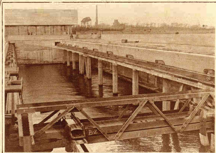
Foto van de tweede sluisdeur, op het oogenblik, dat deze dichtschoot. Zooals men weet slaan deze sluisdeuren niet naar weerskanten open, zooals dat in de oude sluisen het geval is, maar bestaat de afsluiting uit slechts één deur, die in een daarvoor gemaakt „gat” in den wal geschoven kan worden. Deze foto maakte de fotograaf, staande op de tweede deur; men krijgt hier dus een goed denkbeeld van de geweldige grootte van den sluisput.
