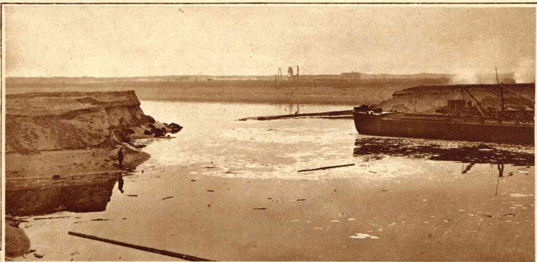
Het gat in den dam, zooals het verwijd was door het voor de eerste maal er door stroomende water.
