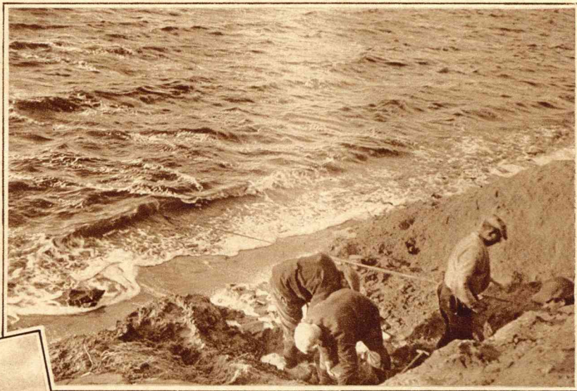
Terwijl de zee lustig op hen aanstormt, blijven de mannen kalm doorgraven, wetend dat er een op den uitkijk staat, om hen tijdig voor mogelijk gevaar te waarschuwen.
