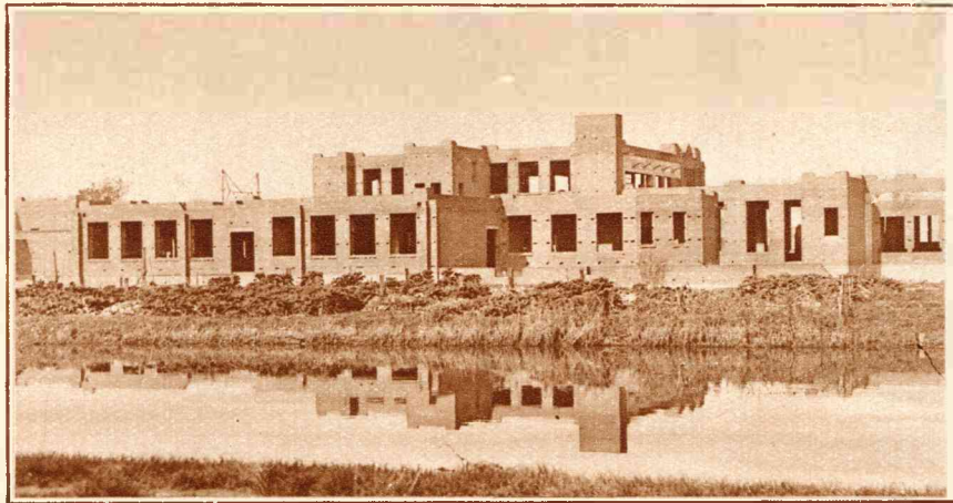
Vele treinreizigers hebben vanuit hun coupé al jarenlang met misnoegen naar dit halfvoltooide gebouwencomplex gezien, dat oorspronkelijk als cigarettfabriek voor de firma Philips gebouwd was. Eindelijk is men er in geslaagd een koper te vinden, want een Amsterdamsche poetsdoekenfabriek gaat weldra, na de algeheele voltooiing, naar Sloterdijk verhuizen, waardoor tevens een einde komt aan deze ontsiering.
