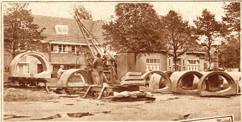
Straten en wegen krijgen een goede beurt, ook het inwendige daarvan. Hiernaast: Op het Wilhelminaplantsoen is men druk bezig met het leggen van een nieuwe rioleering, bestaande uit geweldig groote rioleeringsbuizen.
