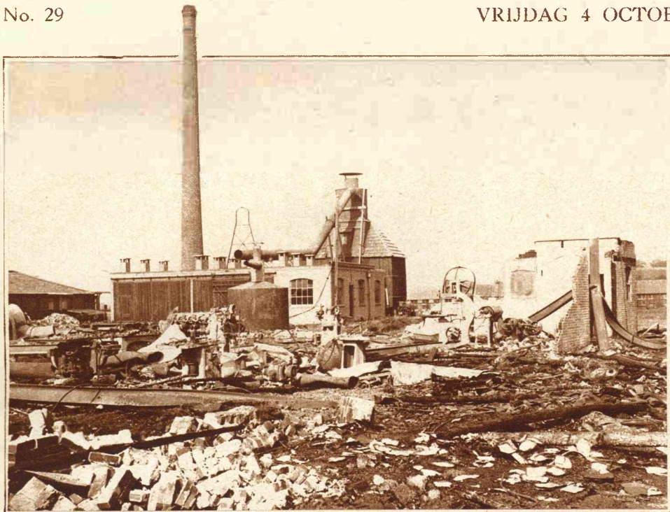
GROOTE BRAND TE LANDSMEER. De vorige week is de Stoomtimmerfabriek der N.V. v.h. Westenberg te Landsmeer totaal afgebrand. Nagenoeg het geheele complex werd een prooi der vlammen, uitgezonderd een houtloods en eenige droogkamers. Een overzichtsfoto van de aangerichte schade hierboven. Op den achtergrond het ketelhuis dat behouden bleef.
