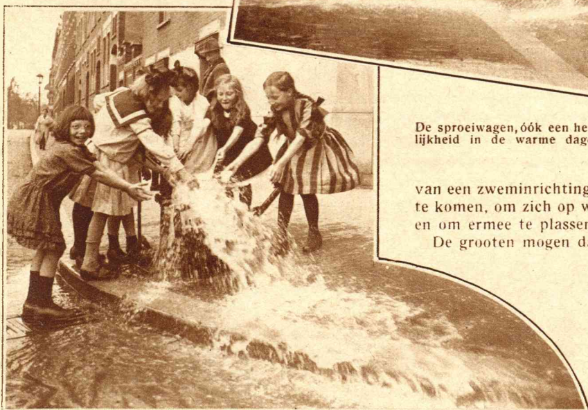
Bij de standpijp der waterleiding.
