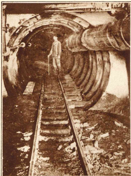
RONDE STEENGANG. Op plaatsen waar de gangen veel vocht houden, is deze ronde constructie toegepast, aangezien dit de eenigste solide en betrouwbare wijze is. Ze zijn als 't ware gemetseld van vierkante moppen beton, met plankjes er tusschen, om de veerkracht te verhoogen bij den aanhoudenden druk der zware wereld die er op rust.... Glück auf!
