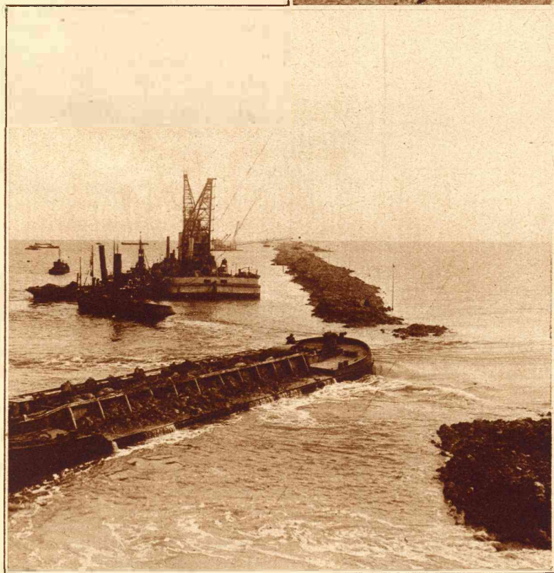
Foto genomen boven één der grijpkranen, toont het sluitgat met een overzicht van den dam naar Medemblik. Duidelijk is hier de stroom waarneembaar.
