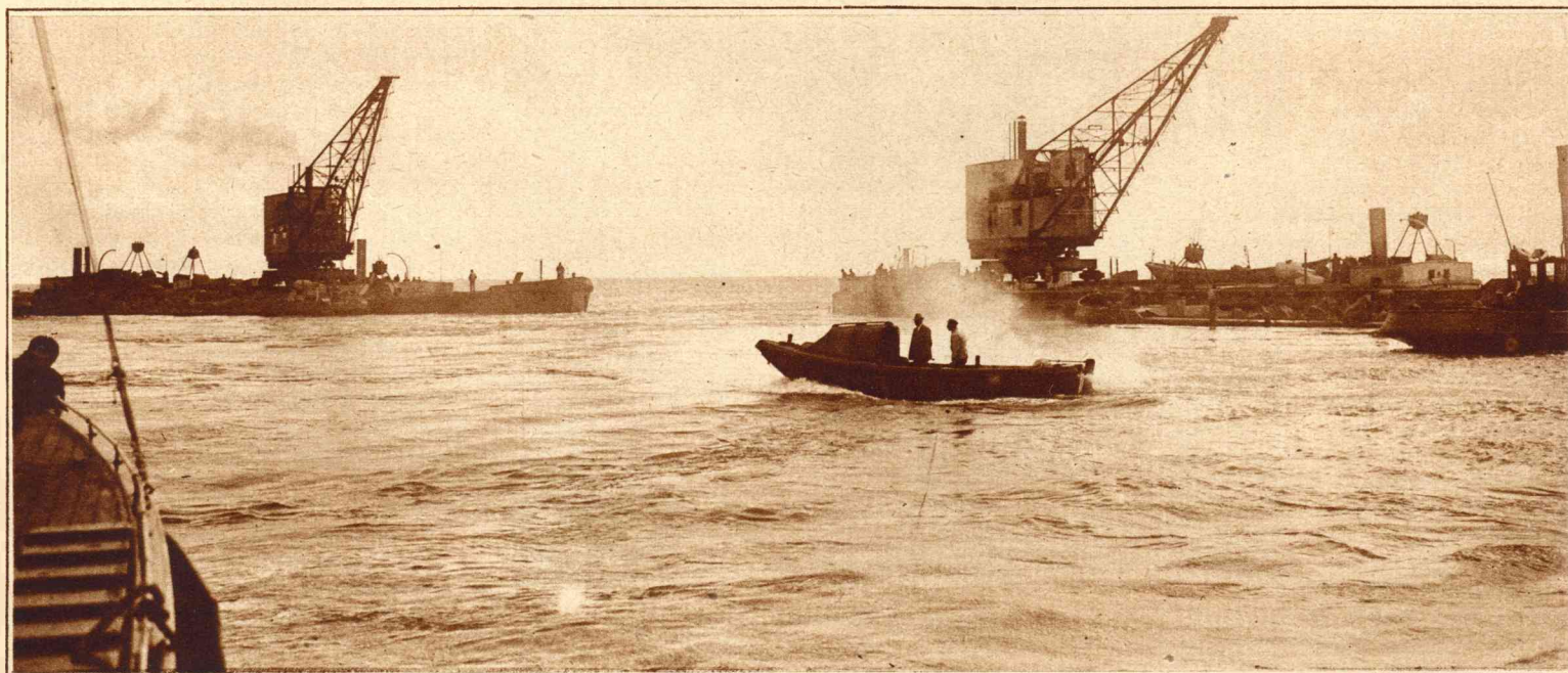
Hier ziet men hoe een der grijpkranen haar werk verricht door den inhoud harer greep in zee uit te storten.
