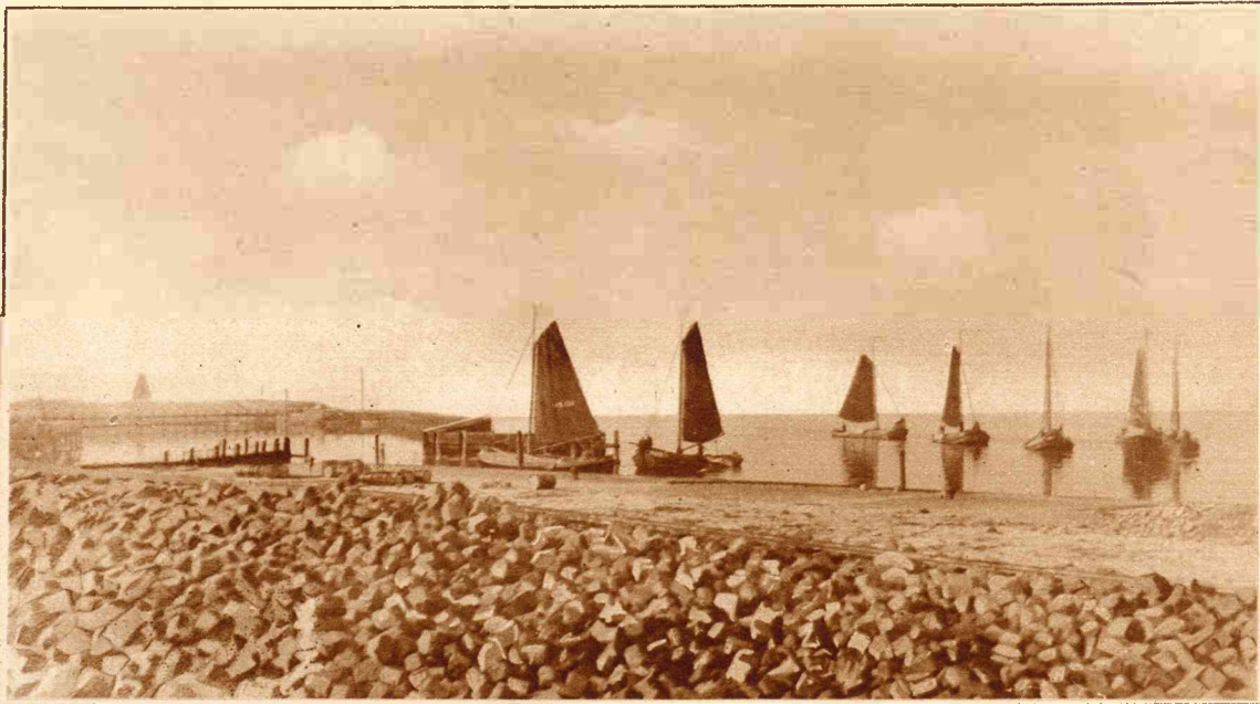
De afsluitdijk van Wieringen.
