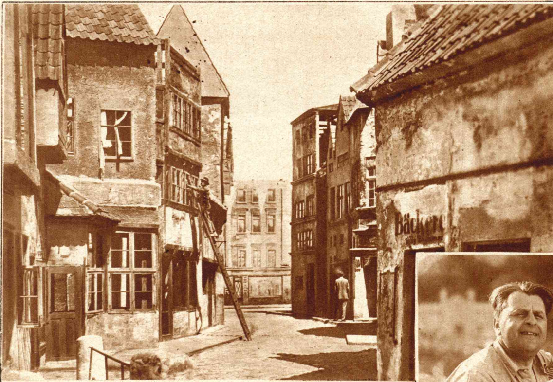
Hoe een straat gebouwd wordt op de Ufa-terreinen. Hout, linnen en cement. Wat men ziet, zijn niet anders dan wanden.
