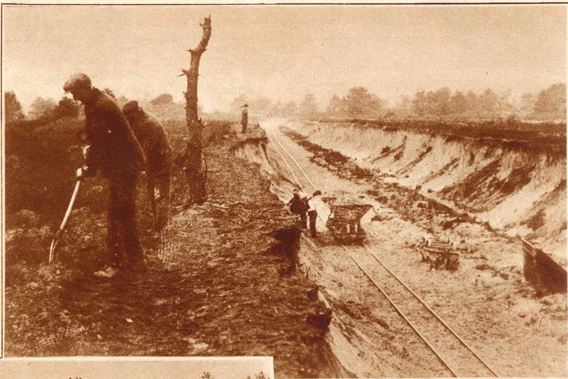
DE AARDKORST WORDT EERST ONTDAAN van de heideplaggen en al het geboomte en struikgewas wordt gerooid, alvorens men graven gaat.
