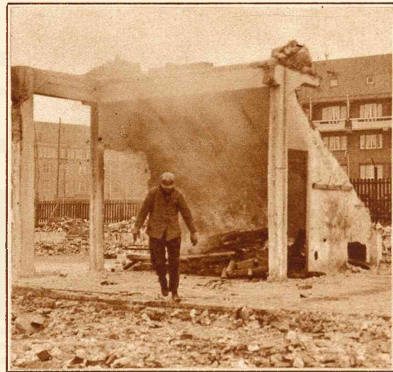
Om het beton gemakkelijker gesloopt te krijgen, wordt het warm gestookt.
