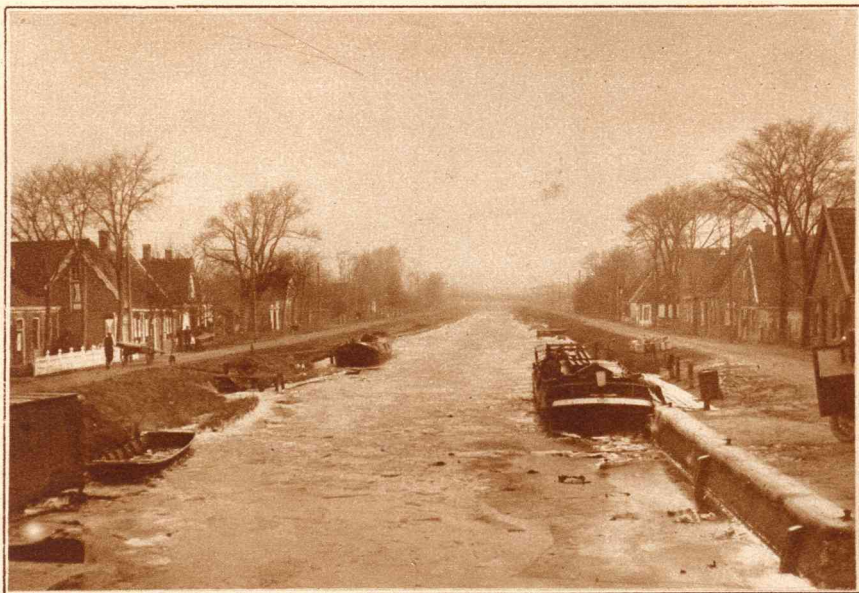
Aan het kanaal te Schagerbrug.
