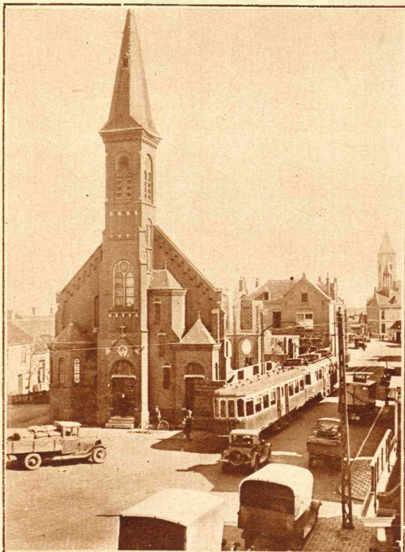
DE LAATSTE FOTO VAN DE R.K. KERK TE HALFWEG, waarvan de voorgevel nog staat, terwijl dak en zijmuren reeds zijn afgebroken. Zoo verdwijnt dan eindelijk het lastige verkeersobstakel, dat midden in den weg Amsterdam—Haarlem lag, hetgeen de drukke passage daar zeer ten goede zal komen.
