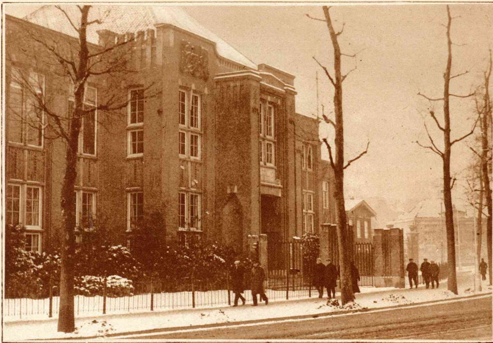
Voorraanzicht van het Hortusgebouw, gezien vanaf het Wertheimplantsoen.
