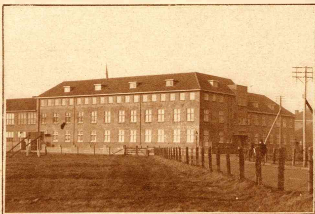
HET ST. LIDUINA-GASTHUIS te Den Helder, van de R.K. Ziekenverpleging aldaar, is uiterlijk reeds voltooid. Bovenstaande foto laat het exterieur dezer instelling zien.
