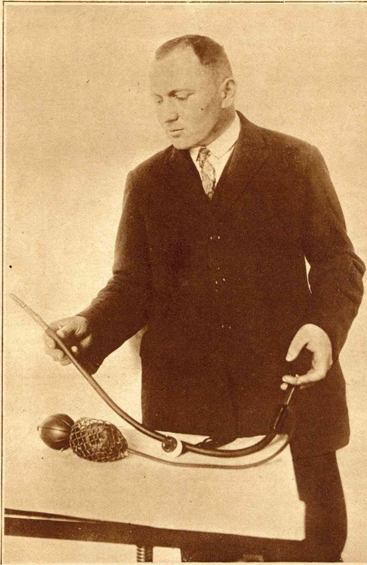
HET FOTOGRAFEEREN DER MAAG is mogelijk geworden door dit apparaat, uitvinding van een Weensch geleerde, hetwelk bevestigd aan een slang in de maag wordt afgelaten. Er bevindt zich een klein lampje in van buitengewone lichtsterkte alsmede 8 kleine stereo-camera's, die het mogelijk maken gelijktijdig verschillende opnamen te maken van het interieur der maag. Met behulp hiervan zal het dus mogelijk zijn een juiste diagnose van maagziekten te stellen.
