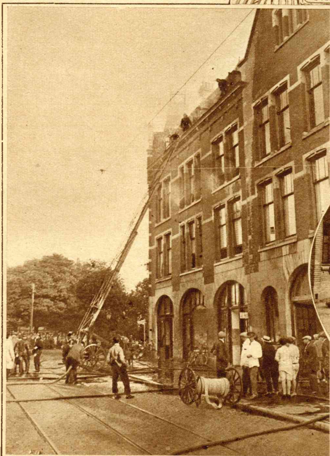
Zaterdagmiddag brak te Haarlem een ernstige brand uit in de bovenverdieping van de melkinrichting „De Sierkan” aan den Zijlweg. Er was voor dezen brand nogal belangstelling. Van het blusschingswerk maakten wij de hierboven afgebeelde foto.
