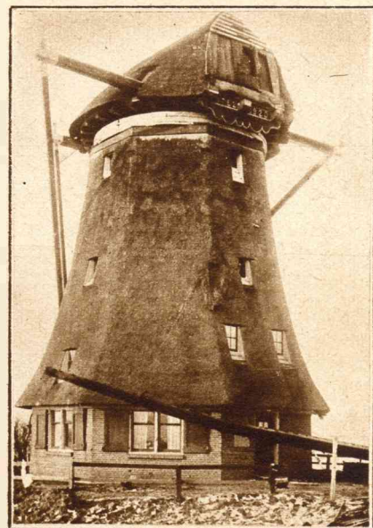
Door het breken van de as is de watermolen van den Stommeerpolder bij Aalsmeer van zijn wieken beroofd.
