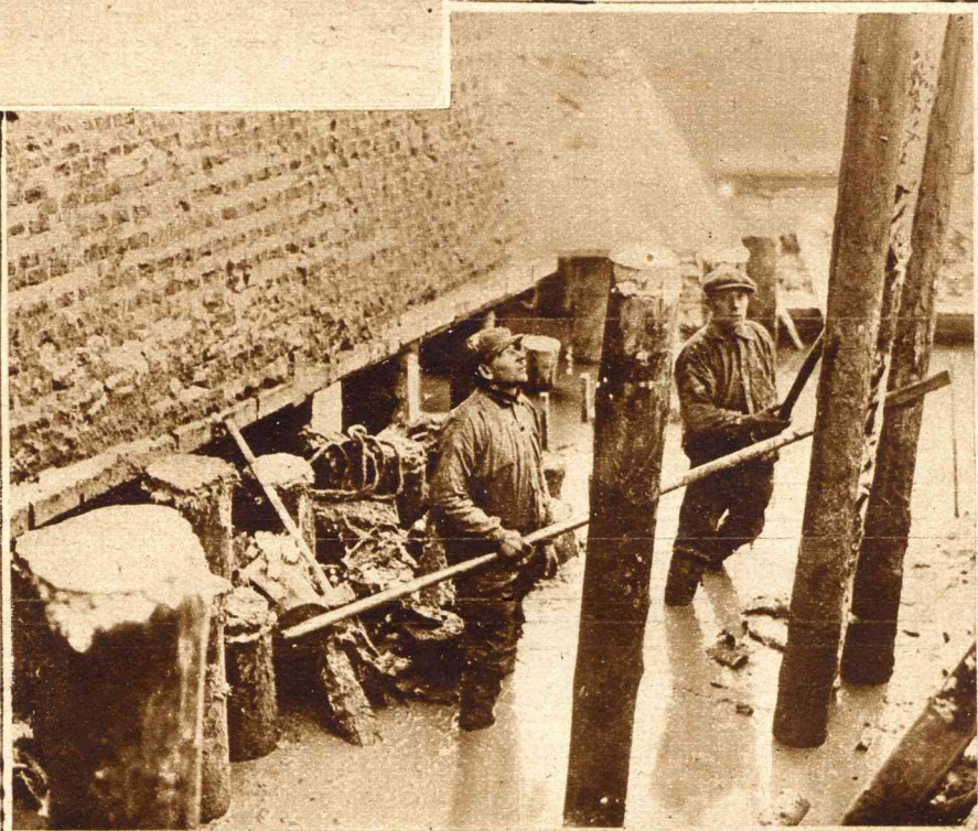
De St. Bavokerk te Haarlem wordt afgebouwd. Op de reeds aanwezige grondslagen zullen twee hoge torens verrijzen. Daarvoor is echter verzwaring der fundeering en heien noodig. Een aardig kijkje op den heikuil in de sneeuw.
