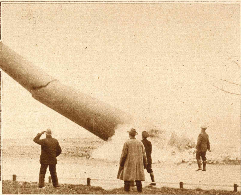
Aan de Maaskade te Venlo werd de 42 M. hoge schoorsteen van de houtzagerij der firma Liebergen naar beneden gehaald. Aan den kant, waar de schoorsteen moest vallen, werden de steenen verwijderd. De „val" van den schoorsteen.
