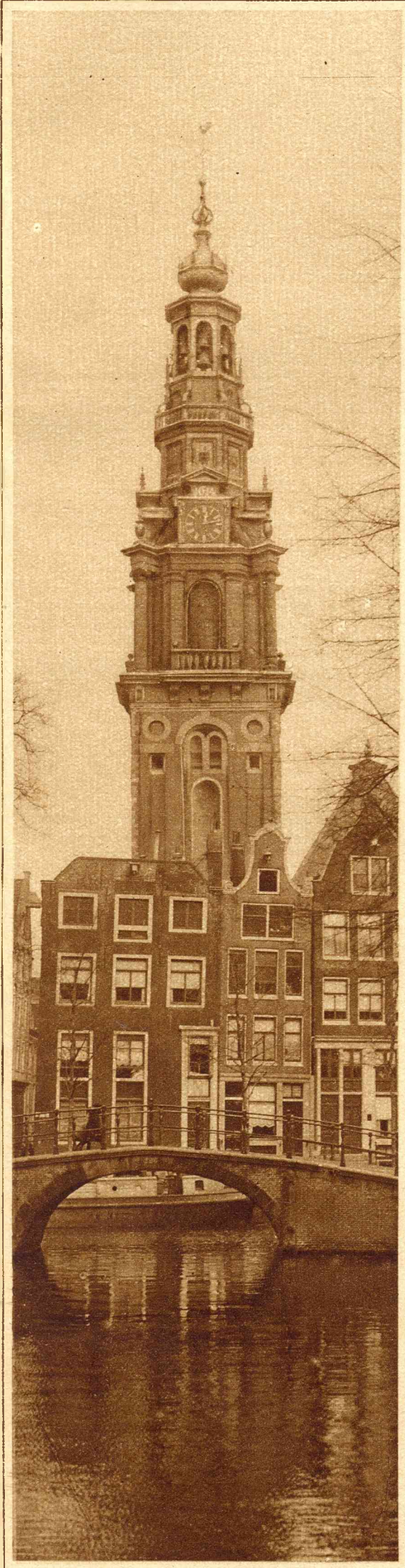
De Zuidertoren in de Zandstraat (1614)
