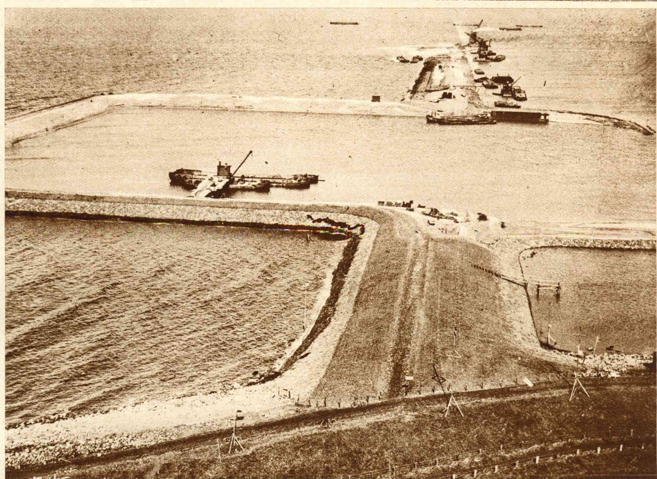
Een overzicht van het werk aan het dijkgedeelte te Medemblik en den gemaalkolk, genomen van den toren te Medemblik.
