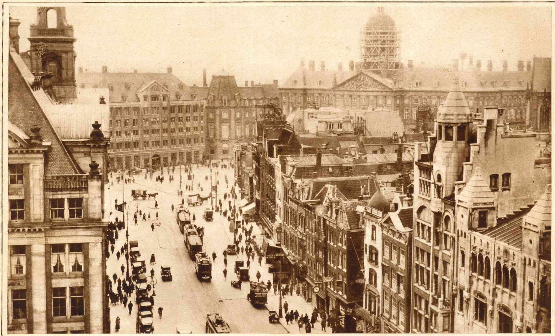
Een foto van het Damrak met op den achtergrond den Dam, genomen van den Beurs-toren. Links een gedeelte van den Noordelijken zijgevel van de Bijenkorf, rechts vooraan het gebouw van de Algemeene. Op den achtergrond de gebouwen van Peek & Cloppenburg en de Grootte Club en daarnaast het Koninklijk Paleis, met den in reparatie zijnden koepel.
