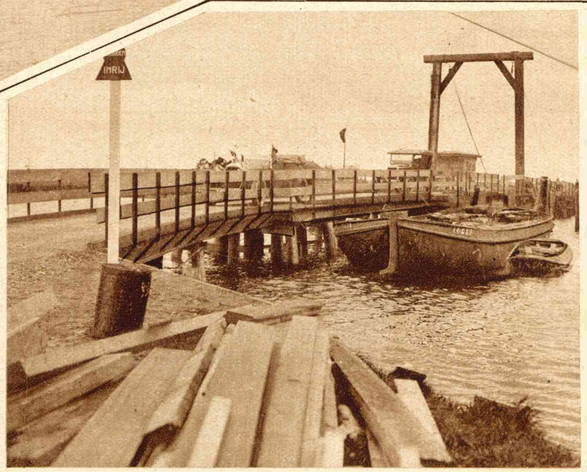
De hulpbrug te Muiden, waarover het verkeer in de richting van Amsterdam naar het Gooi thans geleid wordt.
