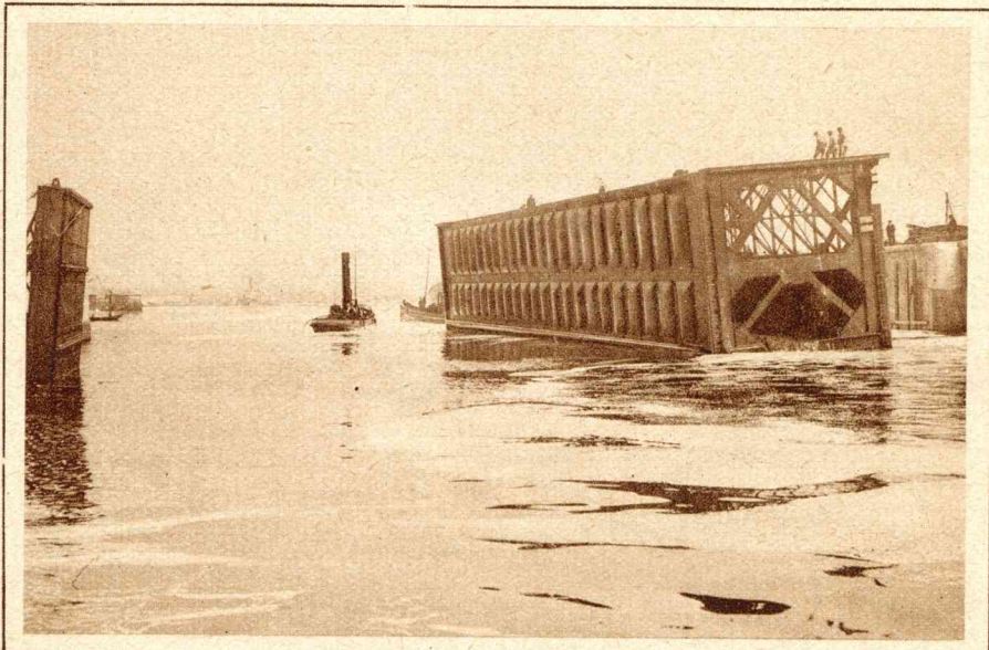
31 Mei was voor de sluiswerken te IJmuiden een belangrijke dag; dien dag is n.l. de eerste groote sluisdeur geplaatst. Het transport van de groote sluisdeur zullen onze lezers zich nog wel herinneren, en nu is dit geweldige gevaarte op zijn plaats gebracht. Van dit bijzonder moeilijke werk hier een paar foto's. Links: Een kijkje op de sluisdeur zooals ze naar het Binnensluishoofd werd gesleept, zooals men ziet ligt de deur nog plat op het water. Door de onderste vakken met water te vullen, kreeg men de deur in verticalen stand (rechts), zoodat ze op haar plaats in de sluis gevaren kon worden.
