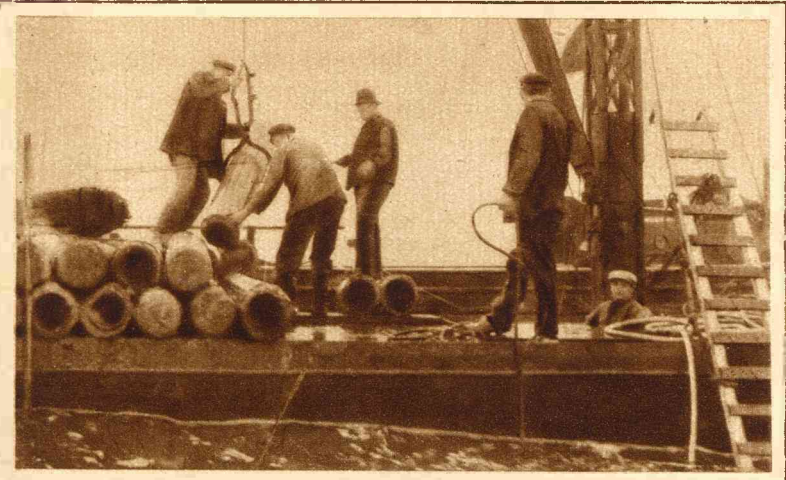
Enige maanden geleden is op het Y te Amsterdam een schuit met 150 betonpaalkoppen omgeslagen. Men is op het oogenblik bezig, ze weer boven water te brengen.
