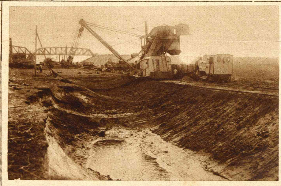
De excavateur graaft den grond uit, die in kipkarren wordt weggevoerd.
