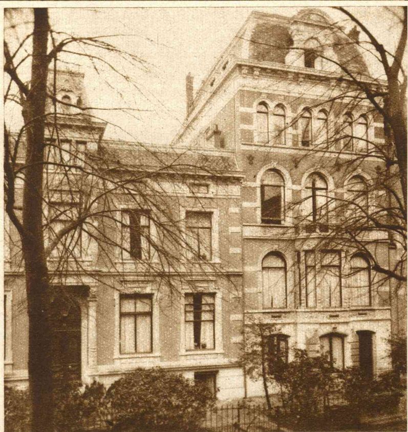
De gebouwen Vondelstraat 35-37.
