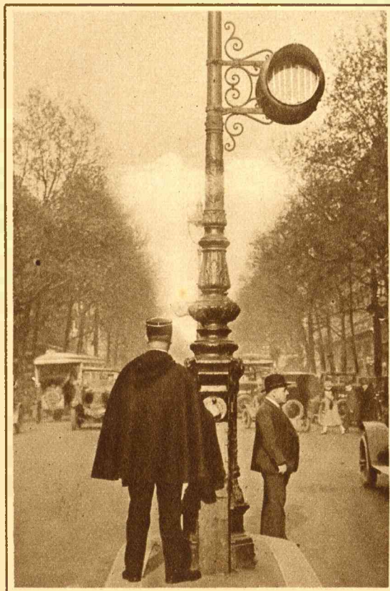
Het nieuwe systeem voor de Parijsche verkeersregeling is in werking getreden. De agent regelt het verkeer met behulp van licht- en geluidseinen. In den voet van den paal is daarvoor een inrichting aangebracht, die den agent in staat stelt de seinen lang electrischen weg in werking te stellen.
