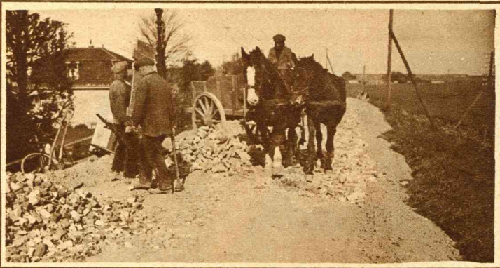
Wegverbetering Zaandam—Westzaan. De Westzanerdijk wordt van Zaandam naar Westzaan voorzien van een macadamlaag, wat op den weg met druk verkeer een groote verbetering is. Men is thans bezig met het storten van het puin voor een stevigen ondergrond (boven) waarvoor groote stenen eerst in kleine stukken worden gehakt (hieronder).
