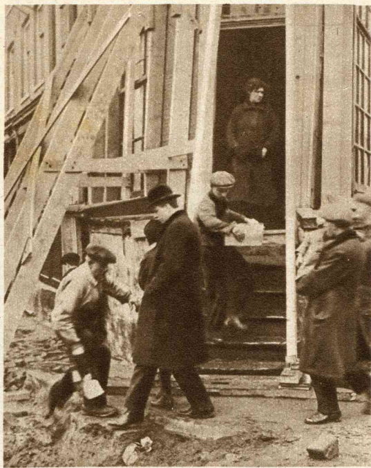
Den 16en Maart moest, op last van Bouw- en Woningtoezicht, het heikwerk aan de Prinsengracht bij de Westerstraat worden stopgezet, daar het gevaar opleverde voor het perceel Prinsengracht hoek Westerstraat, dat, niettegenstaande het stevig gestut was, dreigde in te storten. Den bewoners werd aangezegd het perceel te ontruimen. Links: het gestutte huis; rechts: de bewoners dragen hun inboedel naar buiten.
