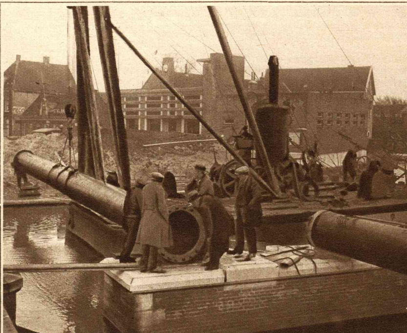
Een kijkje op de werken voor de Amsterdamsche waterleiding te Halfweg, waar door de wegverbreding de zware waterleidingbuizen verlegd moeten worden.
