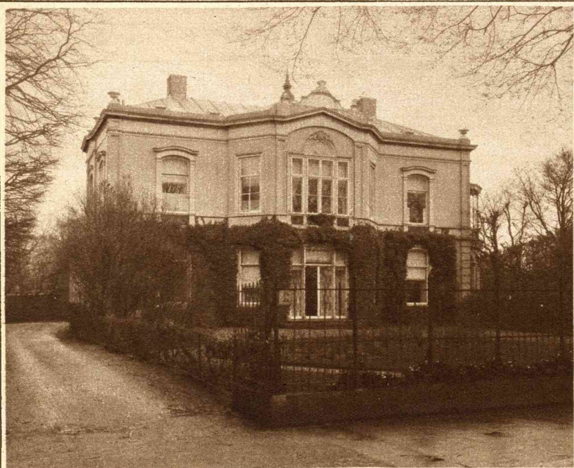
De villa op Plein 1813 te 's-Gravenhage, die zeer waarschijnlijk zal worden aangekocht om te dienen als ambtswoning voor den Minister van Buitenlandsche zaken.
