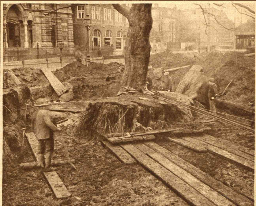
De verplaatsing van den tweeden plataan in het Leidsche Boschje is Zaterdag geschied. Evenals de eerste maal werd ook weer, nadat een lange diepe geul gegraven was van den boom naar de plek waar hij moest komen staan, de grond voorzichtig onder de wortels weggegraven, waarop er planken onder geschoven werden (linksche foto). De bodem van de geul werd eveneens met planken belegd, waarover de boom met den zwaren aardklont waaraan de wortels nog goed vast zaten, met behulp van een lier werd voortgesleept (rechtsche foto).
