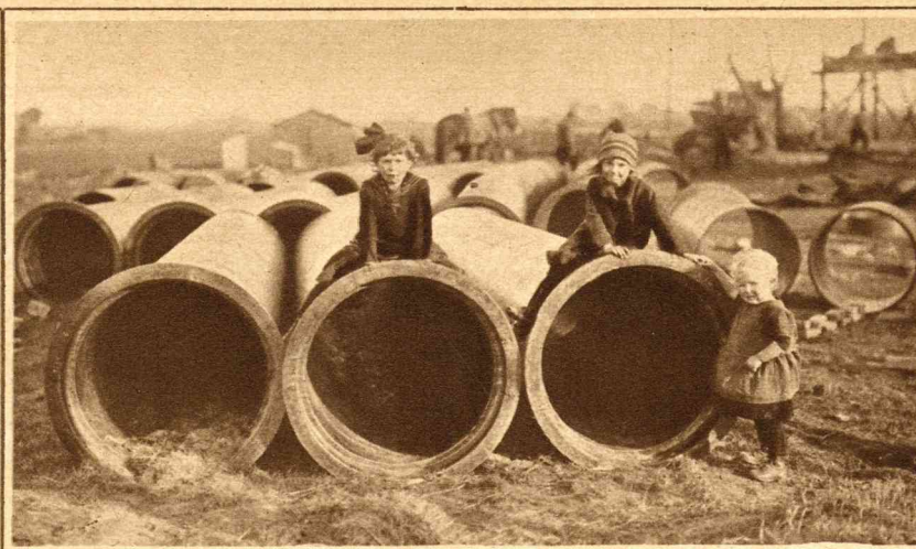
Voor de watervoorziening van Amsterdam is men op het oogenblik druk bezig met het leggen van een transportbuis. De buis wordt in Haarlem aangesloten aan den zinker in het Spaarne, om vandaar te worden doorgetrokken naar Halfweg en Sloten, waar zij aan de stadsleiding wordt aangesloten. Links: Het graven van de geul waarin de buis komt te liggen. Rechts: De buizen, die 90 c.M. in doorsnee zijn; elk stuk weegt 2300 K.G.
