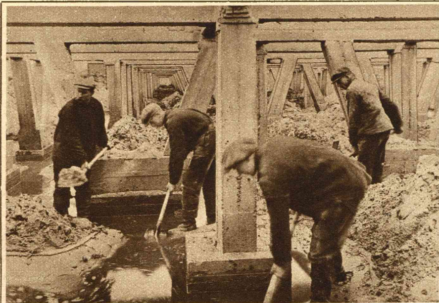
De fundeeringen van het Plan West aan den Admiraal de Ruyterweg zijn in den laatsten tijd nogal besproken. De betonstijlen en balken van een tiental blokken huizen vertoonden scheuren, waarop Bouw- en Woningtoezicht ontgraving en onderzoek heeft gelast. Gebleken is daarbij dat enkele der betonkolommen niet behoorlijk op hun plaats stonden, niet op de houten fundeering. Hierboven een drietal foto's van dit interessante werk. Links: Het opmeten der fundeeringen; de maten worden door den opzichter genoteerd; midden: een geheele fundeering ondergraven; rechts: een betonstijl, omgeven door een nieuwe bewapening, om den stijl dikker te maken.
