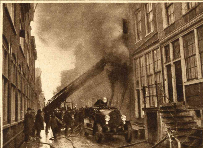
Dinsdag brak een ernstige brand uit in het papierpakhuis der firma Schutte aan de Bickersgracht te Amsterdam, dat geheel uitbrandde. Een foto tijdens de blussing. De zeilmakerij der firma Fijma, op de tweede verdieping leed alleen waterschade.
