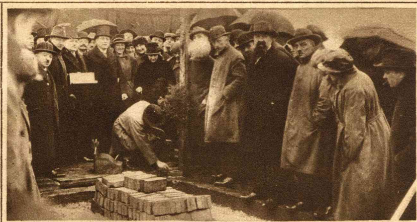
Door de dochter van den burgemeester van Amstelveen, mej. A. G. Colijn, werd deze week de eerste steen gelegd der Witte Stad, de tuinstad die 3000 eengezins woningen zal bevatten.
