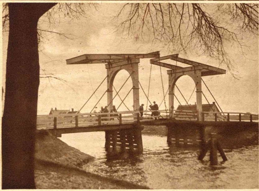
Een der weinige houten bascule-bridgen over het Noord-Hollandsche Kanaal, die in deze omgeving een aardig effect maakt.
