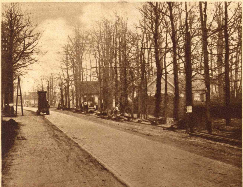
De bekende straatweg De Bilt—Zeist wordt verbreed, om er een dubbel tramspoor te kunnen leggen. Een prachtige verbetering. Jammer maar, dat die gepaard moet gaan met de vernieling van het natuurschoon. Er moeten namelijk een aantal boomen gerooid worden wat het aanzien van den weg zeer zal schaden.
