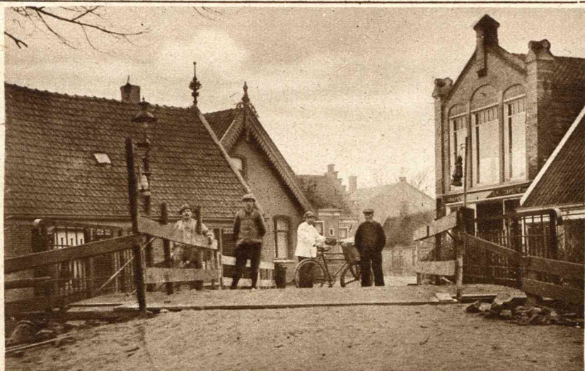
Met het oog op het drukke verkeer daar ter plaatse, wordt de brug te Oud Karspel met 2 M. verbreed. Op de foto ziet men door de noodleuning de oude breedte aangegeven. De ijzeren leuning geeft de nieuwe breedte aan.
