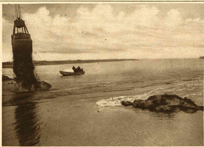
Den 31sten Juli, 's-avonds om 8 uur, heeft Wieringen opgehouden een eiland te zijn. Voor de werken tot drooglegging der Zuiderzee moest tusschen Wieringen en het vaste land van Noord-Holland, bij Ewijcksluis, een dam gelegd worden door het Amsteldiep. Aan beide zijden werd begonnen en allengs naderden de beide dijken elkaar, totdat ze tenslotte Donderdagavond elkaar raakten en Wieringen aan den vasten wal vast zat. Hierboven een foto van den toestand, zooals die niet lang geleden nog was; men ziet de beide einden der dijken en daartusschen een breede strook water; hieronder: De eerste personen, de aannemers van het werk, de heeren Hofman en van Hattem, loopen over den nu aaneengesloten dijk.
