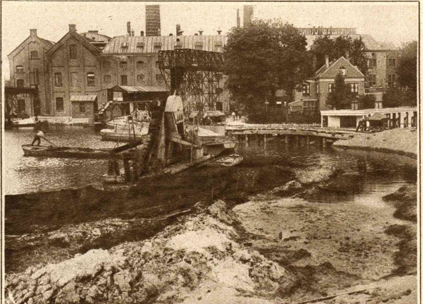
Op de plaatsen waar het veen reeds voldoende is weggebaggerd, is men reeds bezig met het storten van zand. Eerst wanneer dit voldoende is weggezakt en den nog aanwezigen slappen grond heeft weggedrukt en in elkaar geperst, zal opnieuw de vaargeul worden gegraven.
