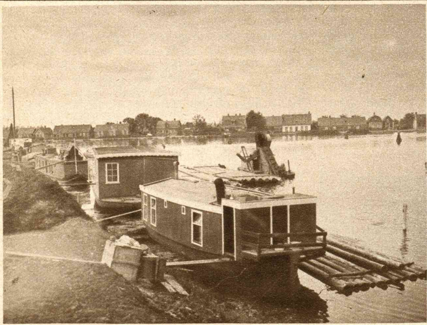
Hierboven twee kiekjes van het wegbaggeren van den slappen veengrond, die door zand zal worden vervangen.
